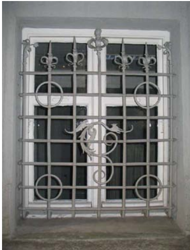
Abbildung 81: Doppelvilla Platz/Kerschensteiner, Detail Kellerfenster, Aufnahme 2004.
