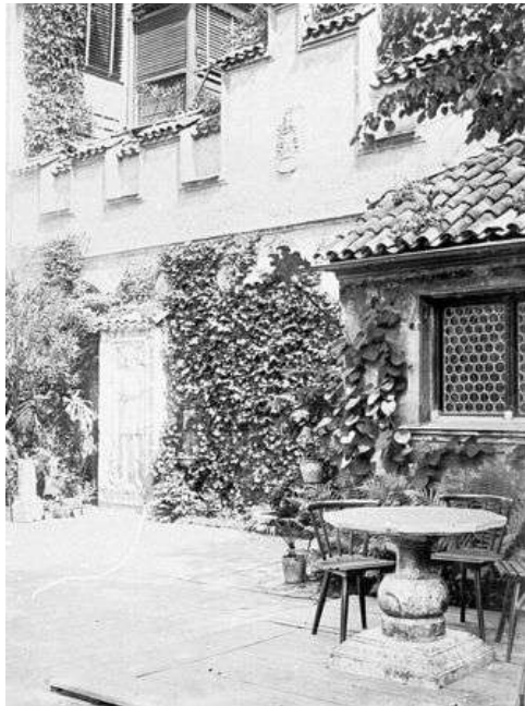
Abbildung 58: Grützner-Haus, Garten, östliche Gartenmauer und Waschküchen, 1887, Aufnahme nach 1886.
