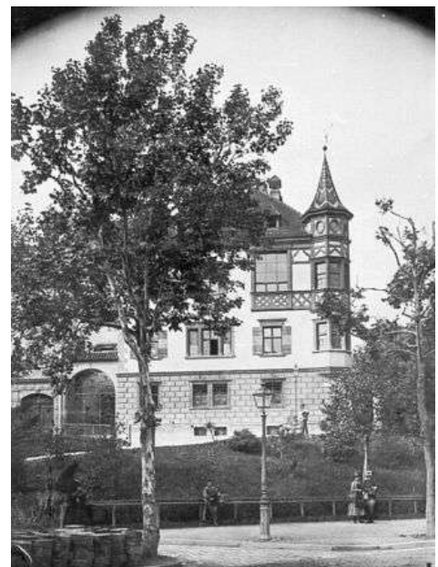
Abbildung 17: Grütznerturm, Nordfassade zur Praterstrasse hin, Aufnahme zwischen 1885 und 1914.
