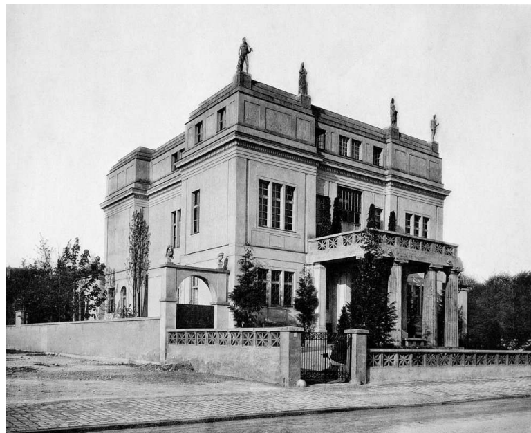
Abbildung 132: Villa von Franz von Stuck, erbaut 1897-98, Entwurf: Franz von Stuck, Aufnahme vor 1905.
