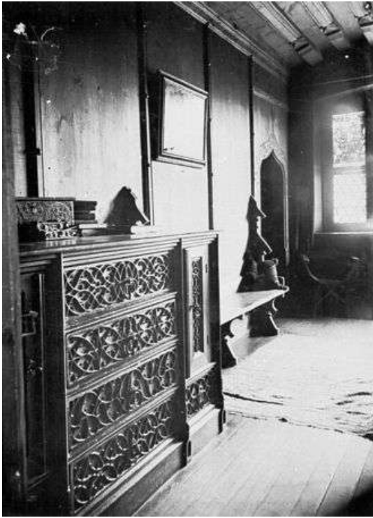
Abbildung 45: Grütznert-Haus, kleines Wohnzimmer nach Nordwesten hin, Aufnahme zwischen 1885 und 1914.
