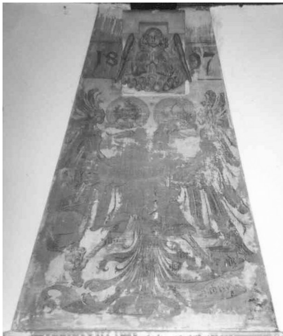
Abbildung 85: Doppelvilla Plaß/Kerschensteiner, Plaß-Hälfte, Kamin im Erdgeschoß, Fassung von 1897, Aufnahme bei Freilegung 1976.
