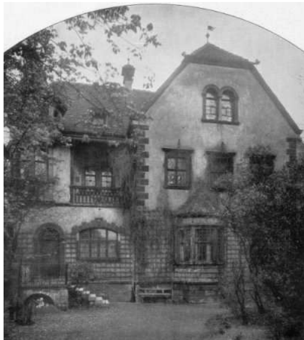
Abbildung 88: Hess-Haus, zur Luisenstraße hin (Südosten).
