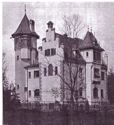
Abbildung 110: Villa Winklhofer, Nordwestansicht, Aufnahme vor 1906.
