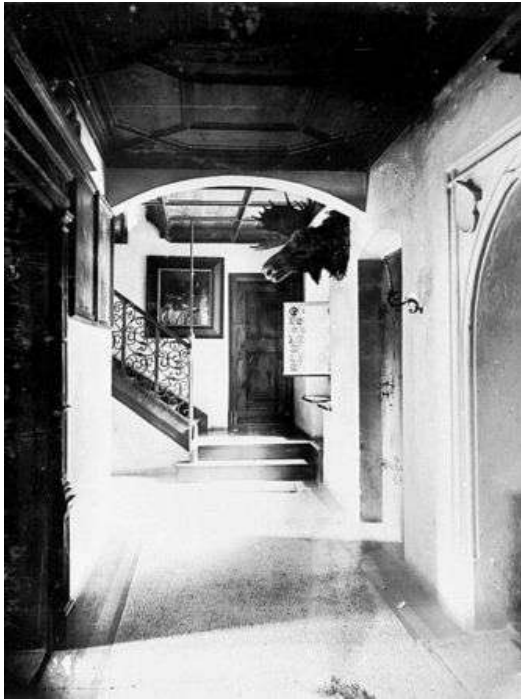
Abbildung 37: Grütznert-Haus, Flur und Treppe Erdgeschoß, Aufnahme zwischen 1885 und 1914.
