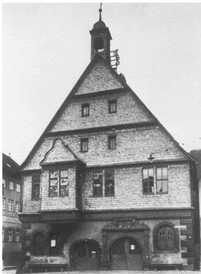
Abbildung 12: Rathaus, Wörth am Main, renoviert ab 1897.
