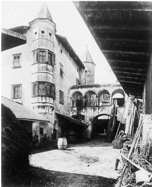
Abbildung 121: Ansicht Wohlgemuth, St. Michael in Eppan (Südtirol, Überetsch).
