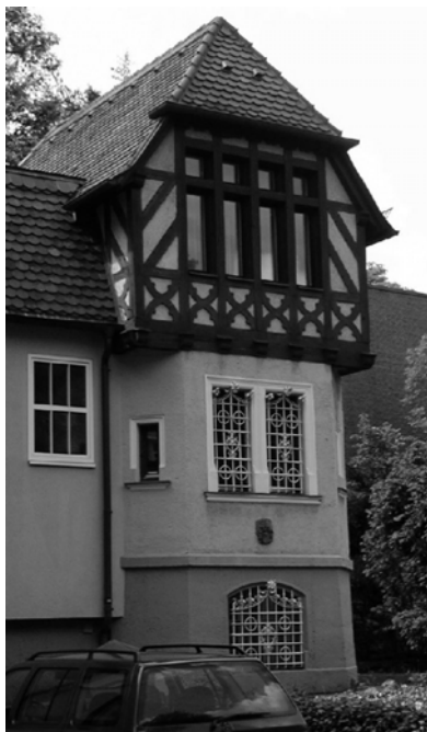
Abbildung 91: Ateliergebäude für Karl von Wullfen, Nordseite, Aufnahme 2004.
