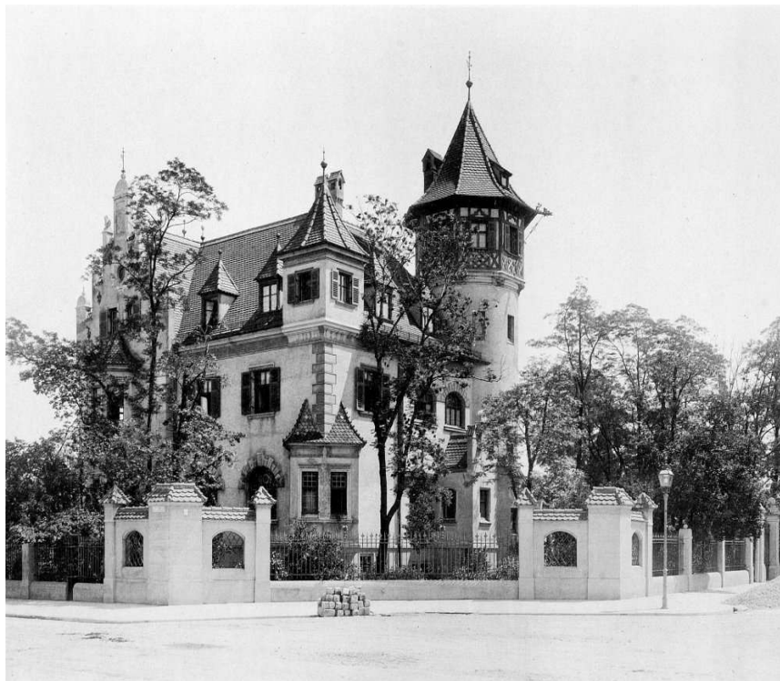
Abbildung 108: Villa Winklhofer, Südostansicht, Aufnahme vor 1905.
