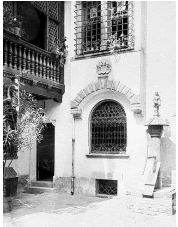
Abbildung 28: Grütznert-Haus, Südseite, Detail Hof, Aufnahme zwischen 1885 und 1914.
