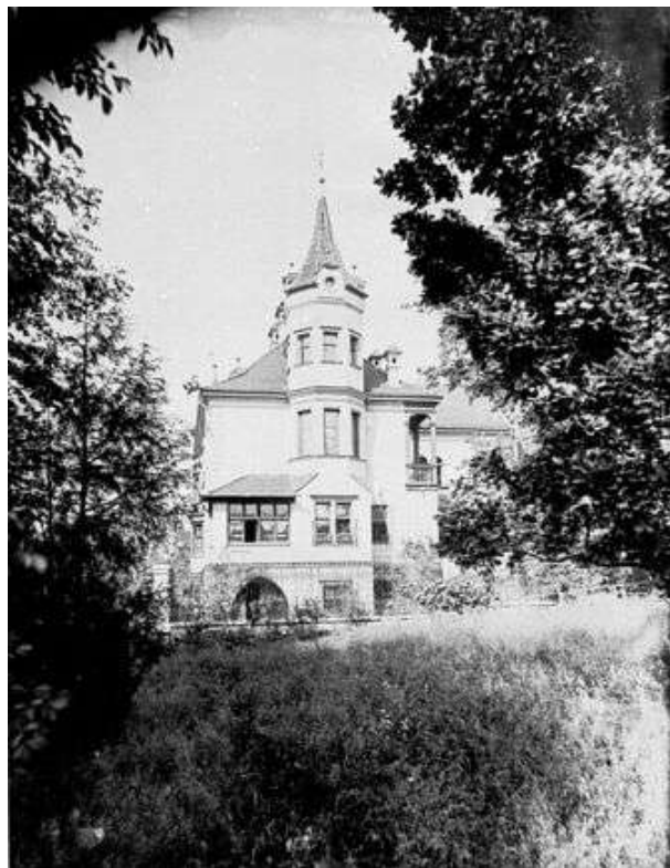
Abbildung 26: Grützner-Haus, Südseite, Aufnahme zwischen 1885 und 1914.
