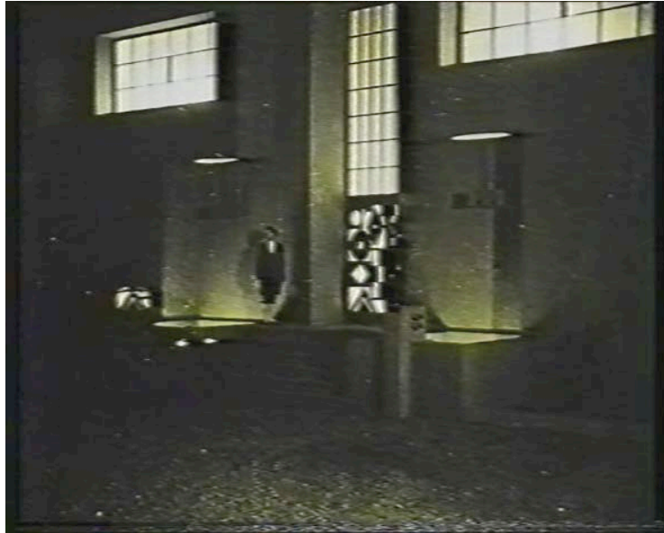
FS 13 E10 Villa der Sängerin, Außenansicht, Eingangsbereich
