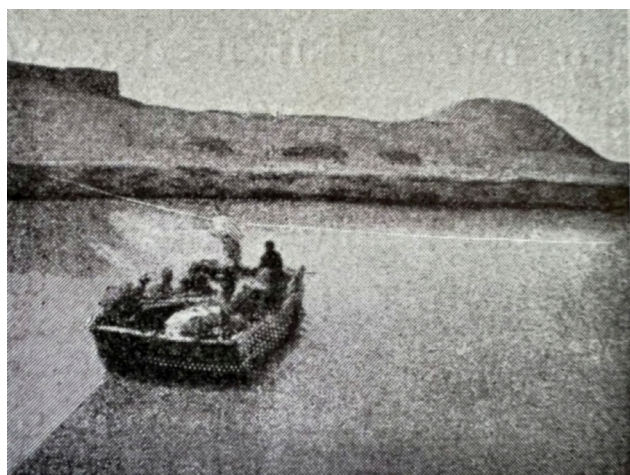
Abb. 6: Überquerung des Hâbûr mit einer Fähre, die an einem Strick (weiße Linie) gezogen wird (SACHAU 1900, 134, Abb. 27).
