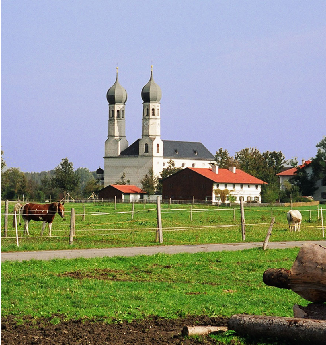
1. Weihenlinden, Ansicht von Südwesten
