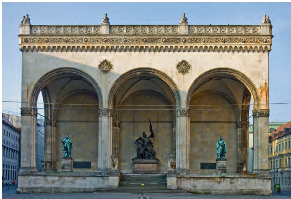
Die Feldherrnhalle in München. Ansicht von Nord, links die Residenzstraße, rechts die Theatinerstraße.
