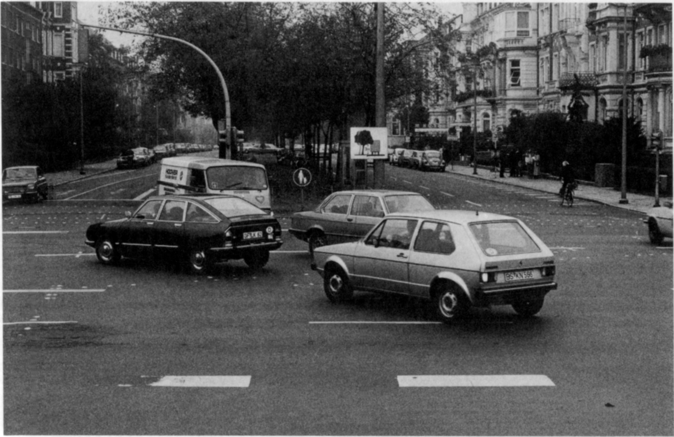
Bild 1: Innenbereich eines Knotenpunktes mit Lichtsignalanlage: Die Linksabbieger warten, bis der Geradeausverkehr durchgefahren ist
