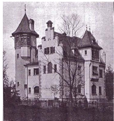
Abbildung 110: Villa Winklhofer, Nordwestansicht, Aufnahme vor 1906.
