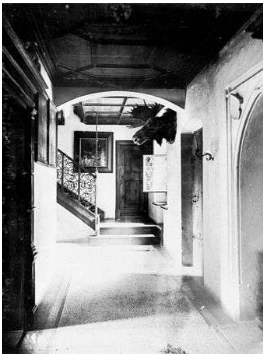
Abbildung 37: Grützner-Haus, Flur und Treppe Erdgeschoß, Aufnahme zwischen 1885 und 1914.
