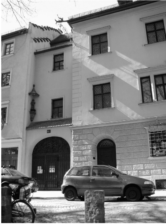
Abbildung 18: Grützner-Haus, Nordseite, östlicher Teil, Aufnahme 2004.
