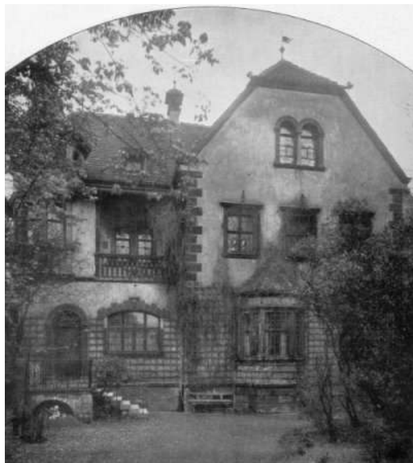
Abbildung 88: Hess-Haus, zur Luisenstraße hin (Südosten).
