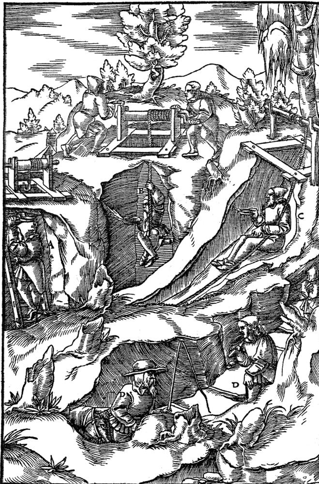
Ein Bergmann, der auf der Fahrt einführt A.<sup>49)</sup> Einer, der auf dem Knebel sitzt B. Einer, der auf dem Leder einführt C. Auf Stufen, die im Gestein hergestellt sind, Einfahrende D.
