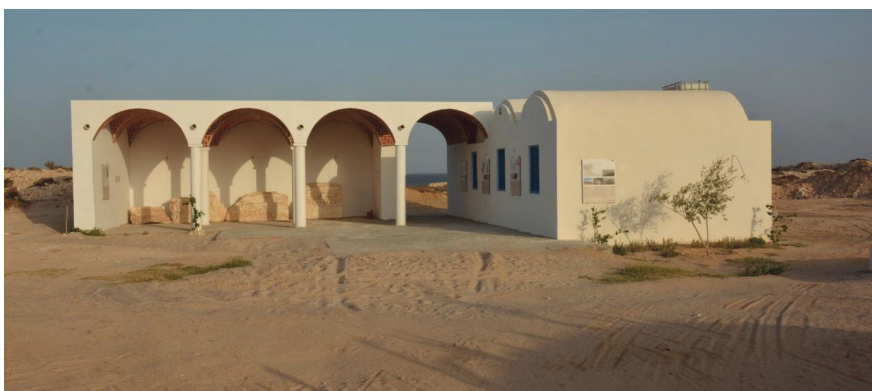
Fig. 8 : portique d'information (photo S. Ritter).
